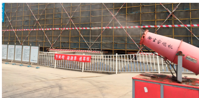
工地“雾炮”降尘
