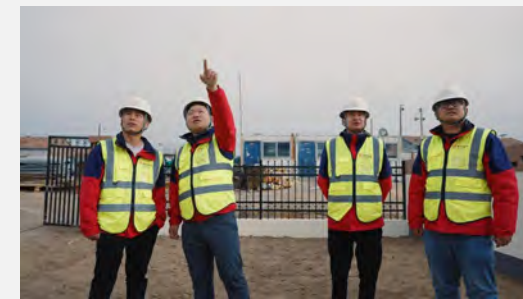
张北华润希望小镇建设施工现场
