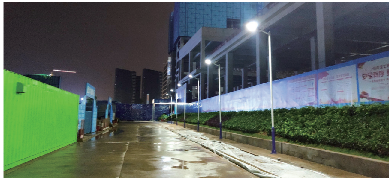
施工现场太阳能照明
