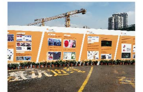
隔音板围挡阻隔噪音传播
