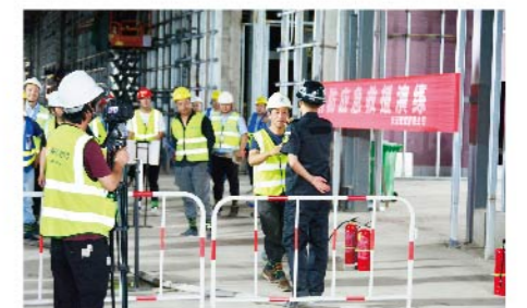
西安丝路国际会议中心东区项目消防应急救援演练新
