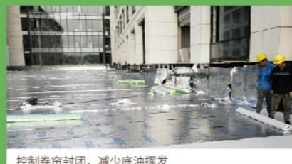
控制卷帘封闭，减少底油挥发
