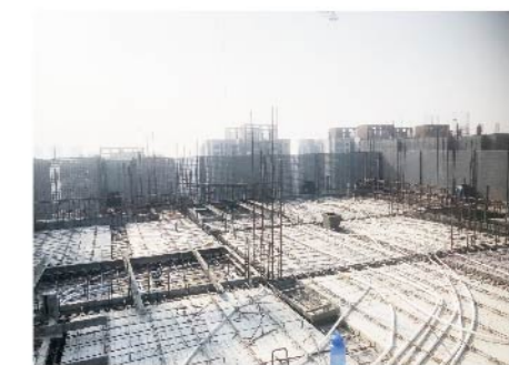
华润置地琨瑜府项目运用叠合板
