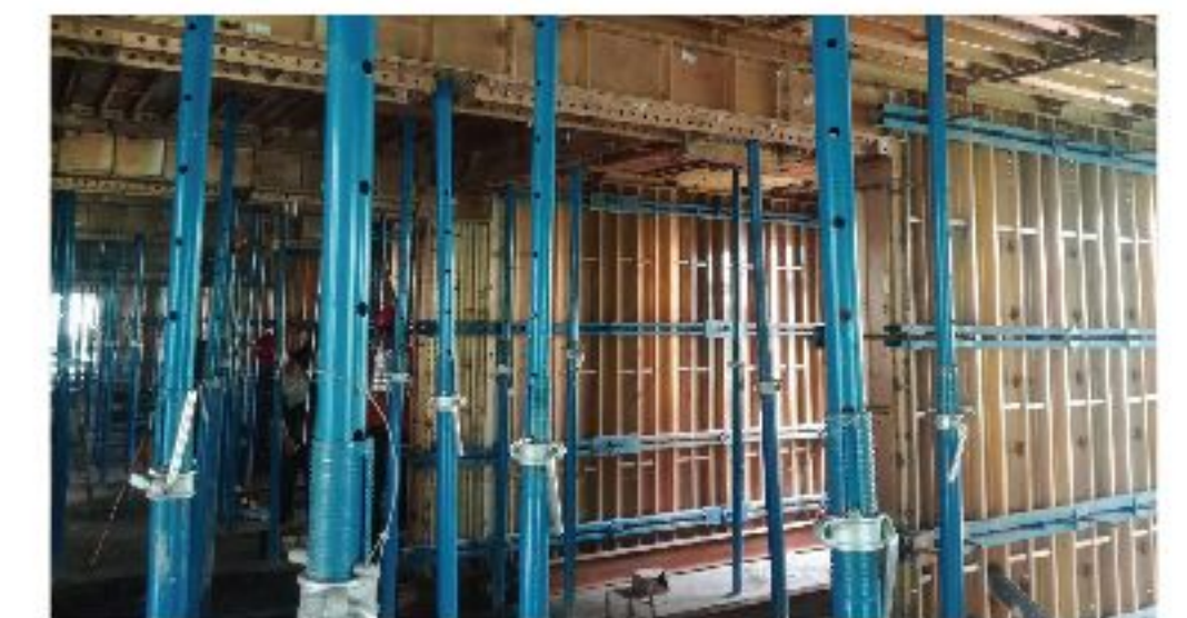
沈阳二十四城 装配式建筑
