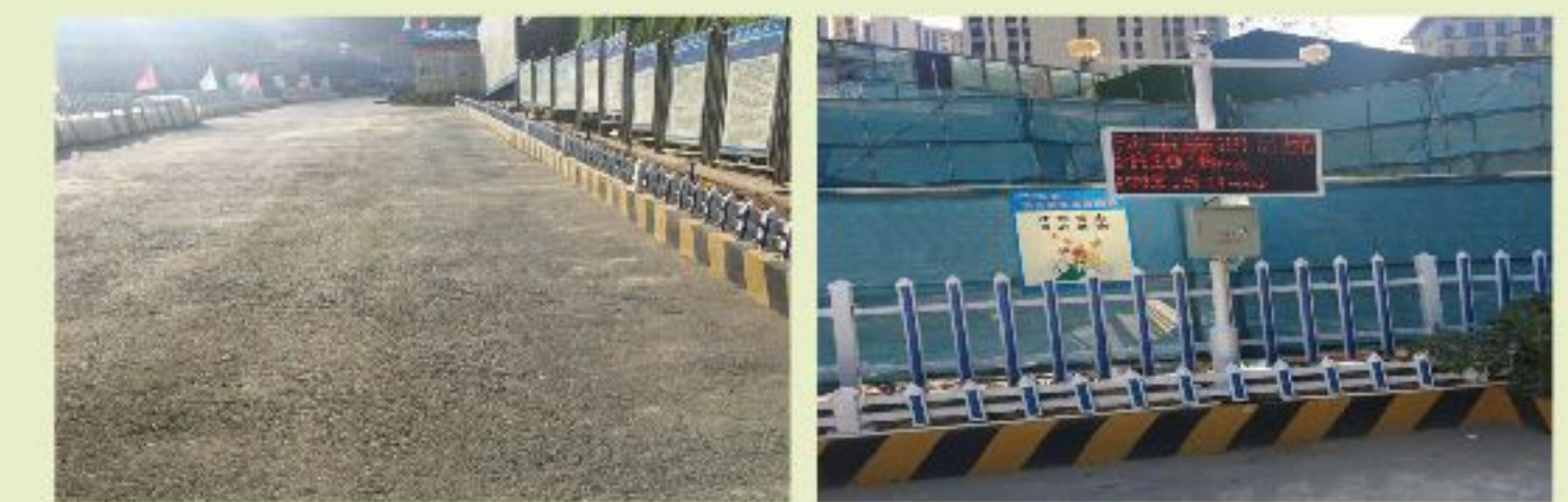
施工现场每日清扫
