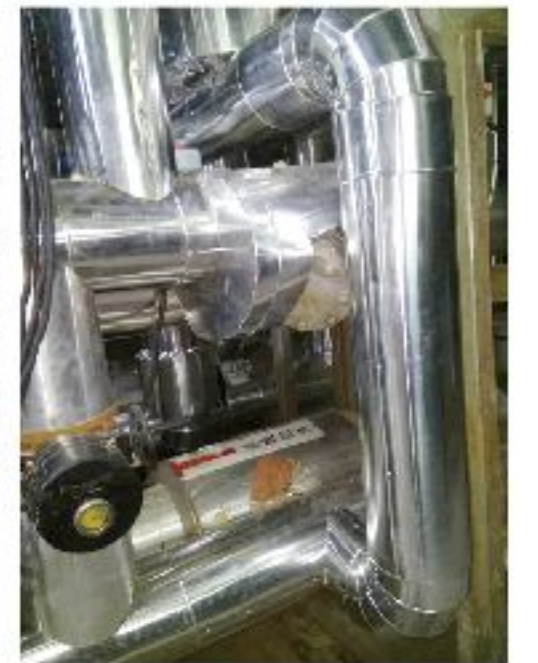
沈阳君悦酒店锅炉改造
