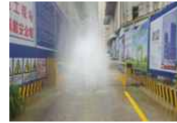
施工大门自动冲洗
