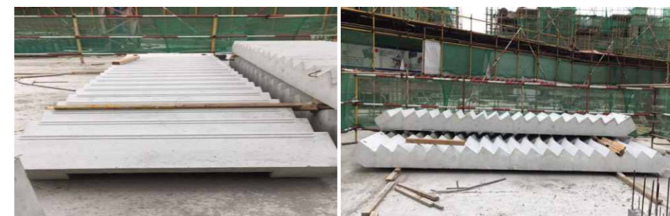
龙湾御府项目消防楼梯与空调板成品构建
