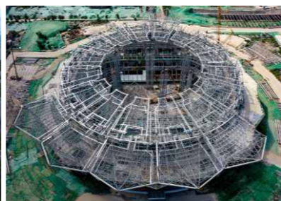
正在建设的西安奥体中心
