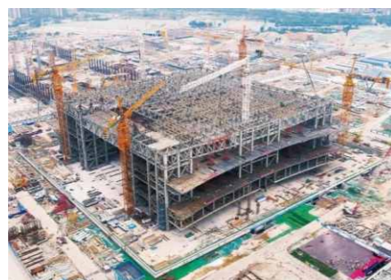
正在建设中的西安丝路国际会议中心
