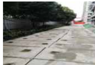
工地工具式道路
