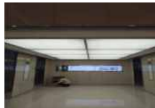
商场LED灯照片
