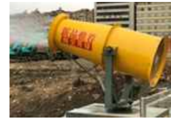
施工现场雾炮器
