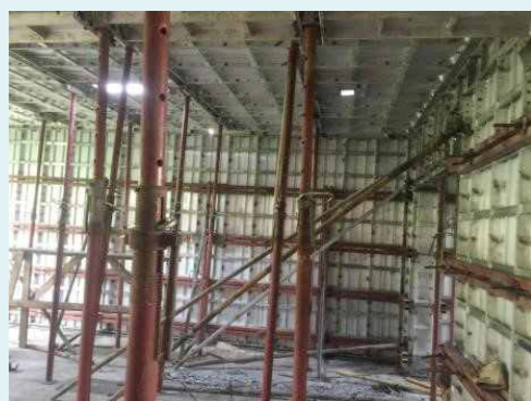
铝模板施工工艺
