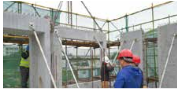
PC 施工现场
