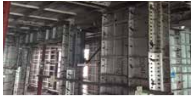
铝模施工现场
