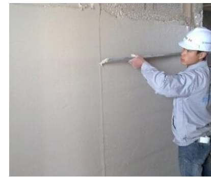
薄抹灰工艺 - 南京幸福里、常州国际、无锡橡树湾、上海静安府
