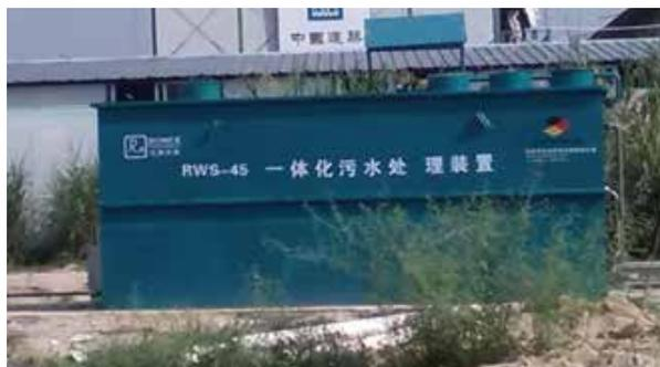
小径湾项目工人生活区，虽然已经有了三级沉淀池，但为了使生活污水排放达到环保标准，排污路由加装了一体化污水处理装置，生活污水经一体化地理式污水处理设施处理后，确保达到《广东省水污染物排放限值标准》DB44/26-2001中的第二时段的一级排放标准及当地政府提供的相关出水水质要求。
