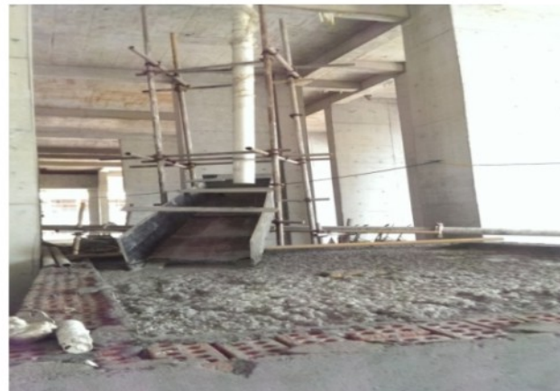
施工用水集中收集循环使用
