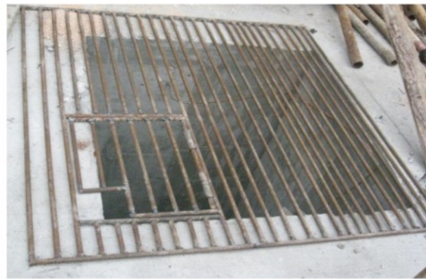
废旧钢筋做成首层洞口防护
