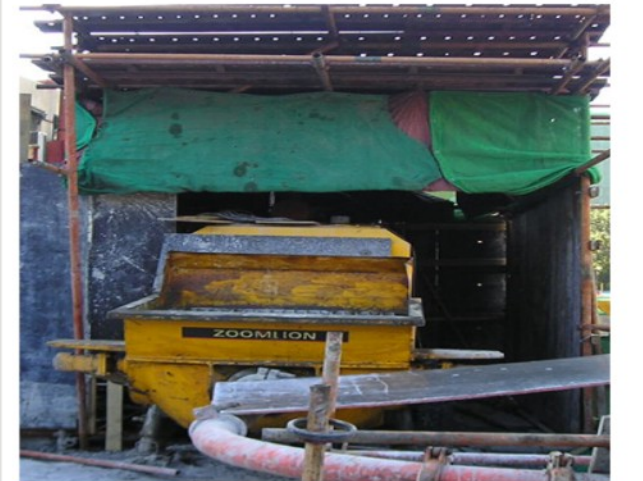
混凝土输送泵隔音棚
