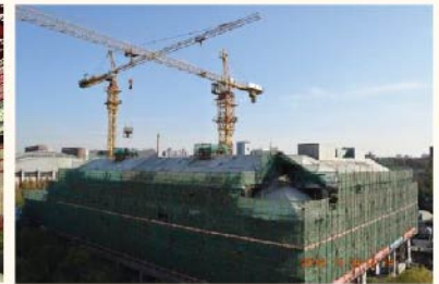
2014年10月20日主体封顶
