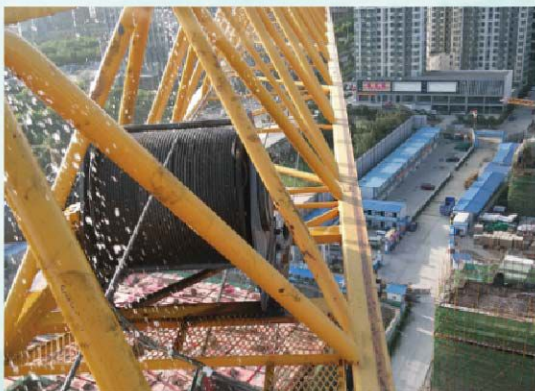
日照凯旋门塔吊喷淋系统图
