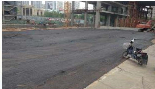
青岛悦府项目裸土覆盖
