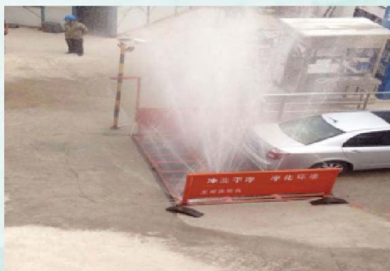
烟台凯旋门项目洗车设施
