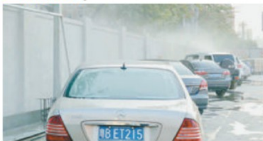
工地围墙设置喷雾器，降低粉尘
