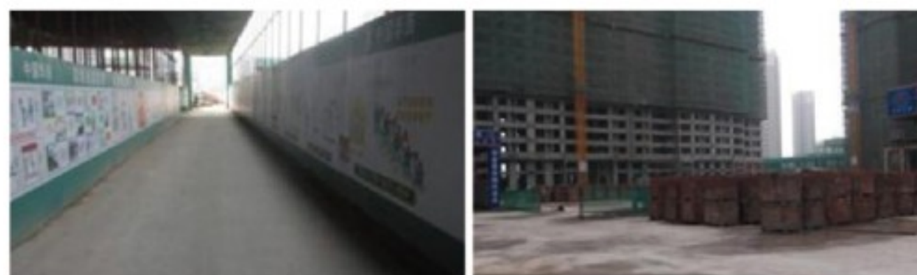
施工现场清扫、洒水，整洁美观
