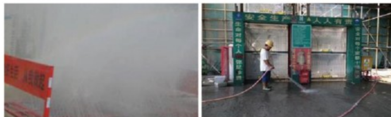
出入口设置洗车池，抑制扬尘
