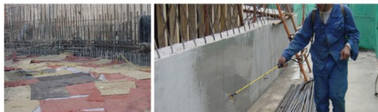
混凝土养护采用覆盖保水养护 墙体采用混凝土养护剂或喷水养护，节约施工用水。
