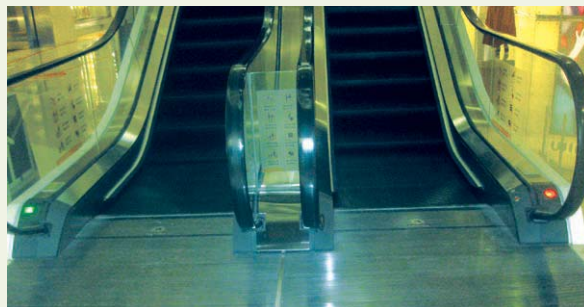
▲ 改造后的沈阳万象城扶梯
